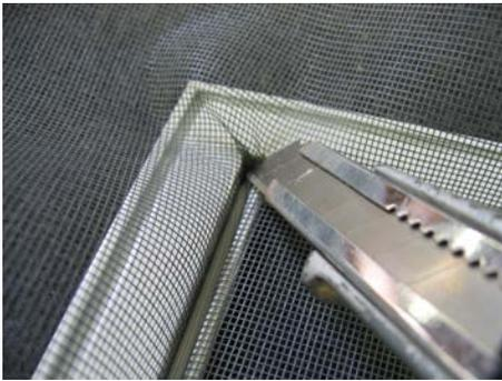
Entfernen des Gewebeüberstandes. Wie beim Einrollen des Gummikeders wird in einer Ecke des Spannrahmens begonnen. Mit äußerster Vorsicht das Gewebe dicht am Gummikeder mit einem Teppichmesser ringsum abschneiden.
