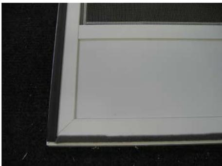
Sockelblech einlegen, Sprossenprofil festschrauben.
