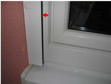
Prüfen, ob genügend Platz für die Montage eines Spannrahmens vorhanden ist. Links und rechts müssen jeweils mind. 10mm, idealerweise 15mm Luft zum Mauerwerk bzw. zur Rollladenschiene sein. Oben und unten müssen jeweils mind. 15mm Luft vorhanden sein.
